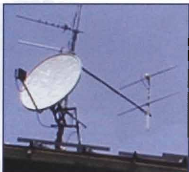
foto 2: Yagi 2 elementi puntata verso il cielo
